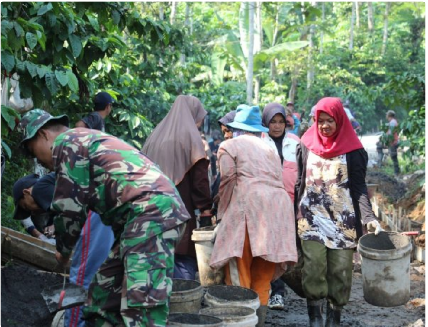
Ibu Ibu Bantu Percepat Pembangunan TMMD
